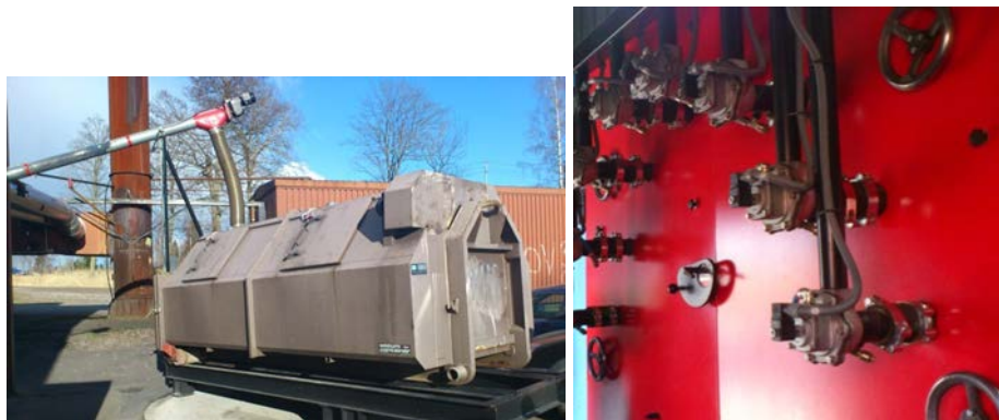
Figur 8. Vål dimensionerat askkär för rörlensaska och automatsotning.
