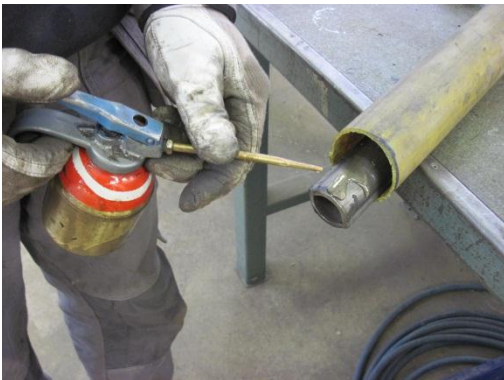
Figur 12. Smörj båda rören ordentligt på ut- respektive insidan.
