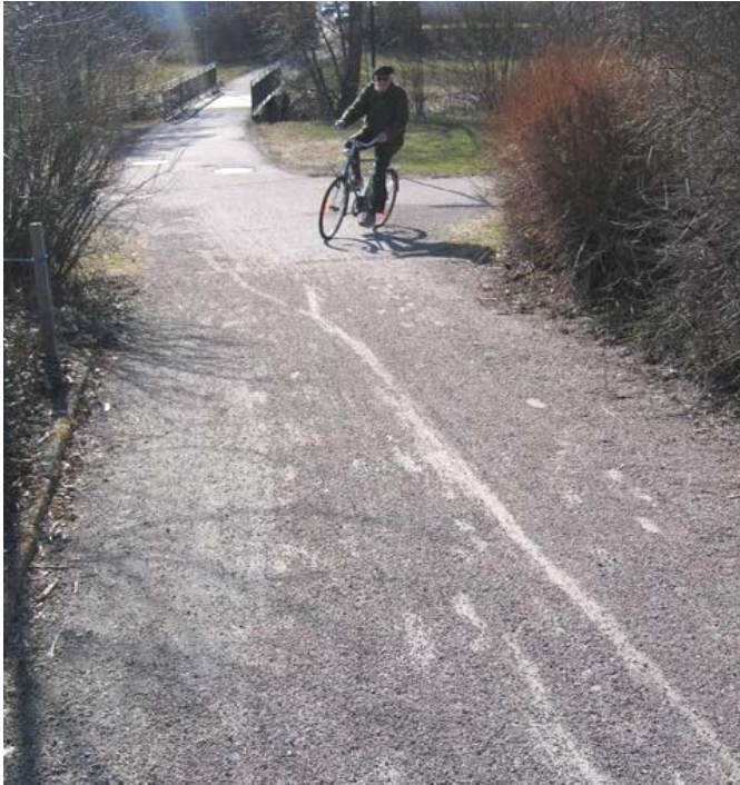
Figur 15 Grus från vintersandningen ligger ofta kvar långt efter vinterns slut och ger ett försämrat väggrepp på cykelvägen. Framförallt i backar kan det leda till att cyklister cyklar omkull. Foto: Anna Niska
