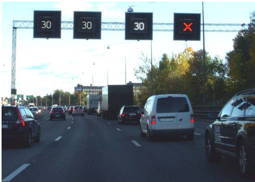
Figur 1 Motorvägsstyrningssystem (MCS) på Essingeleden i Stockholm. Foto taget 2010 av Holger Ellgaard, publicerat på www.wikipedia.org (hämtat från internet 2011-04-13).
