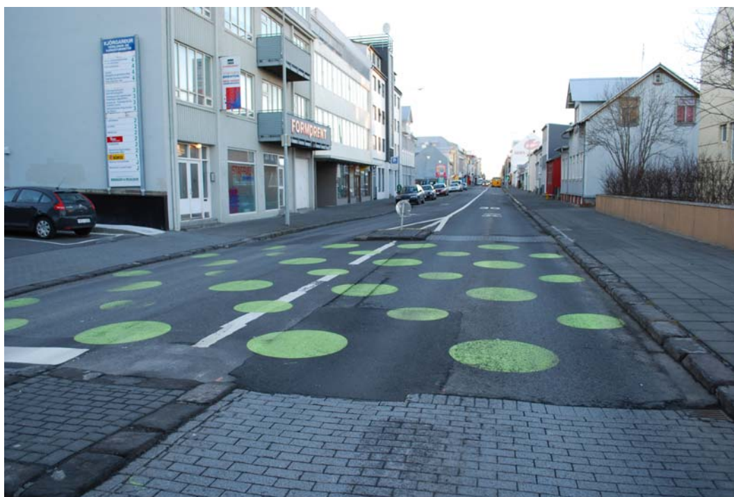
Figur 4 Vägmålningar med gröna cirklar framför/efter övergångsställen på hårt trafikerad gata i centrala Reykjavik, Island. Foto: Annika Jägerbrand, 2010-11-09.
