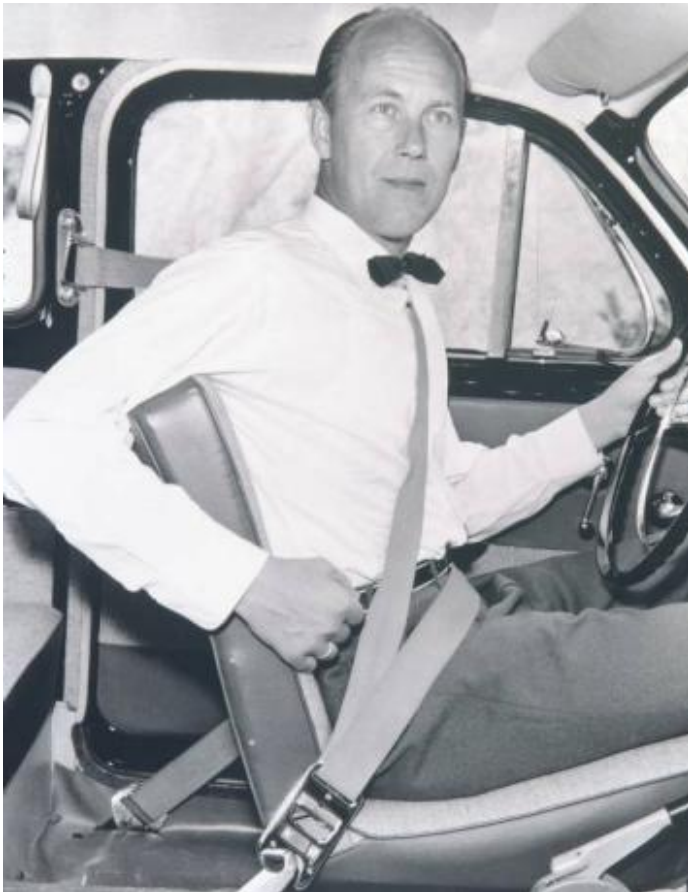
Figur 1 Nils Bohlin, som uppfann trepunktsbältet, testar sin uppfinning 1959. Foto från Volvo.
