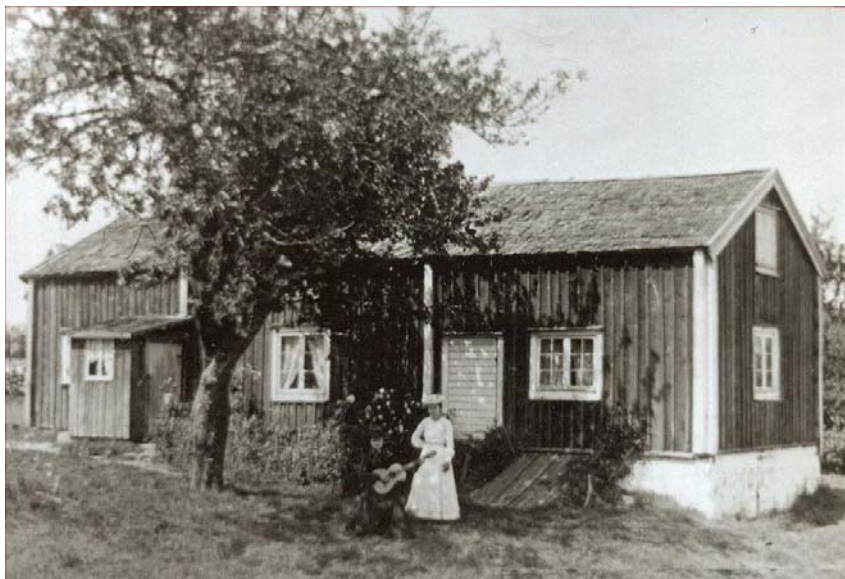
Hos Ola Mattsson på Hallö 1904. Huset byggdes av Olas far, skiftesdelägaren Mats Ingemansson. Källa: Björn Waldenströms bildarkiv.
