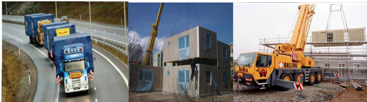
Figur 3: Exempel på transport och montering av volymelement. 8
