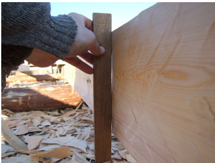
Kontroll så behugningen har samma karakteristiska in- och utbuktningar som originalet. Södra Råda gamla kyrka. Foto: Thomas Hagaeus.
