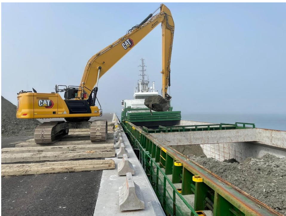
Figur 7: Lossning av kalkstabiliserad lera i Trelleborgs hamn. (Foto: Jonas Bramsved).
