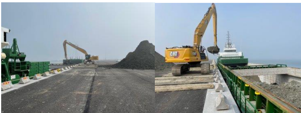
Figur 18: Lossningen av kalkstabiliserad lera i Trelleborgs hamn. (Foto: Jonas Bramsved)
