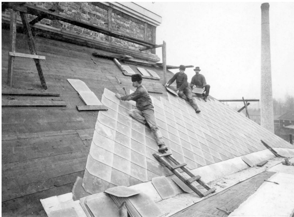
FIGUR 2: Takläggning på NK:s verkstäder i Nyköping. Tidigt 1900-tal. Bilden ur Skandinaviska Eternit AB:s arkiv.
