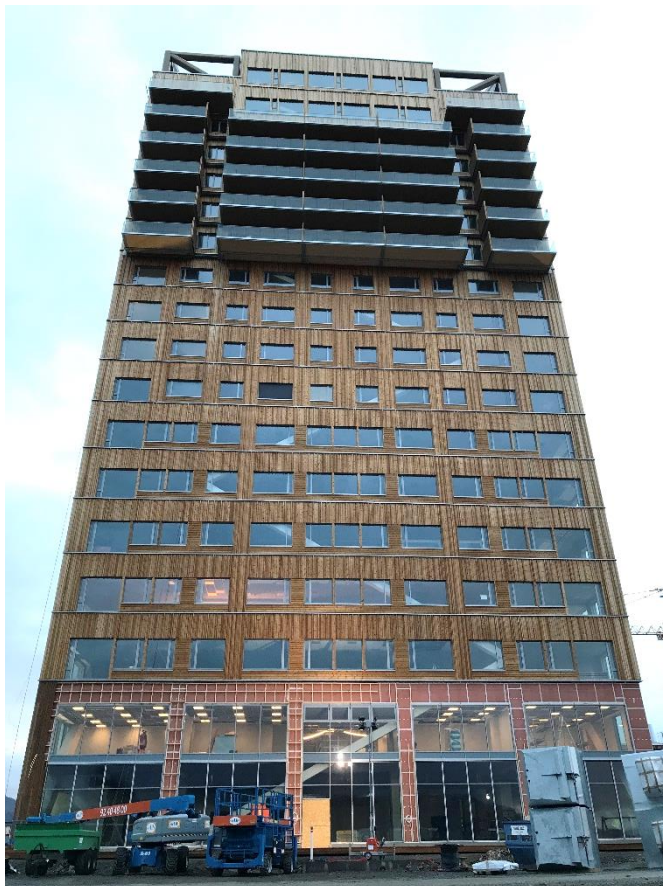
Figure 1. Mjøstårnet in Brumunddal, Norway.
