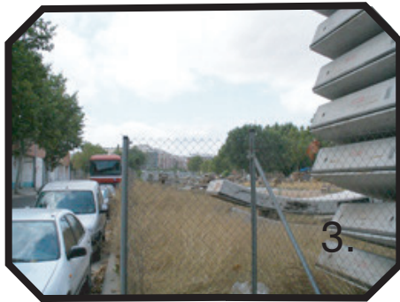
Rambla de Prim ett odefinierbart gaturum, används som avställningsplats för tunga betongelement.
