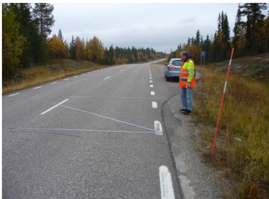
Hastighetsmätningar före fräsning – september 2008
