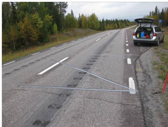
Hastighetsmätningar efter fräsning – september 2009
