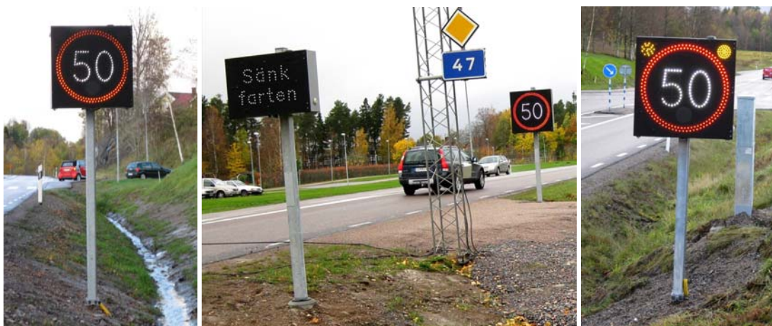
Figur 1 Exempel på de VMS som används i studien. Till vänster visas en 50-skylt som tänds då förare passerar i en för hög hastighet, i mittenbilden visas även tilläggstavlan med texten ”Sänk farten” och till höger visas de kompletterande blinkande ljusen.
