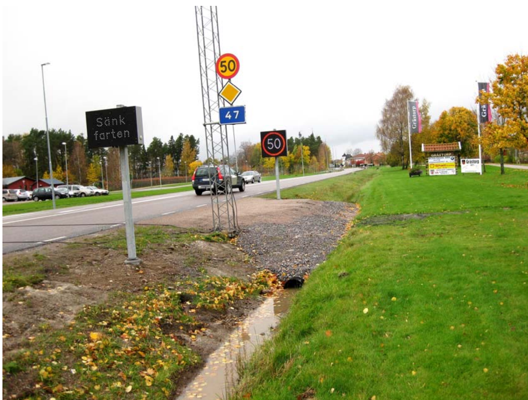
Figur 2 Skyltdesign och placering av variabel hastighetsbegränsningskyld med tilläggstavla på riksväg 47 utmed östra infarten i Grästorps. Foto: Håkan Wilhelmsson
