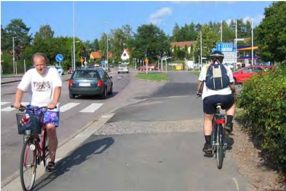
Figur 7 Avgrävd cykelväg i Linköping, till följd av ledningsarbeten. Fotot är taget av författaren, i september 2006.
