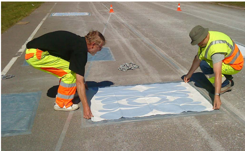
Figur 5 Utläggning av duk på den ljusblå plastfilmen. Foto: Niclas Odermatt, Skanska.
