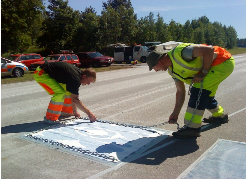
Figur 6 Duken förankras med kätting. Foto: Niclas Odermatt, Skanska.
