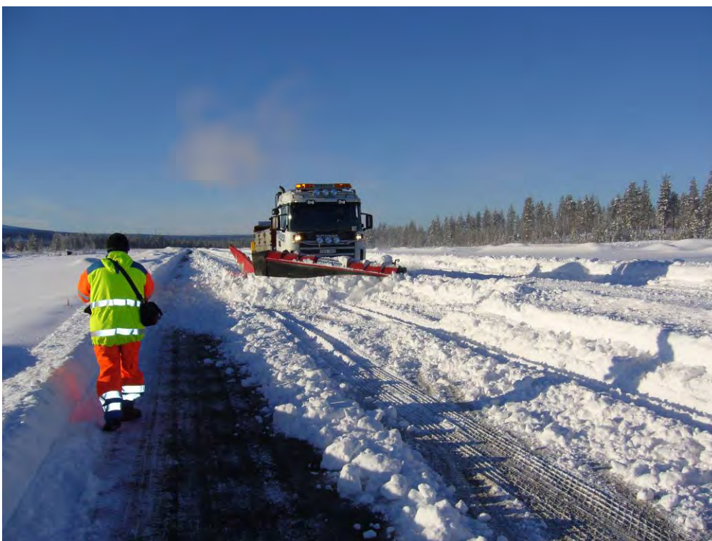
Figur 1 Teststräckan håller på att prepareras före plogning. Foto: Staffan Möller, VTI.
