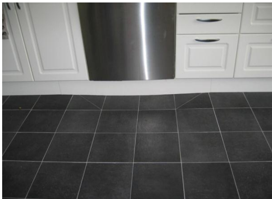
Figur 8.8. Kök med klinkergolv med fall mot installerad golvbrunn. [27]
