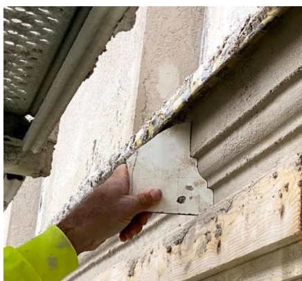
Figur 4.) kalkputsnings renovering av taklister
