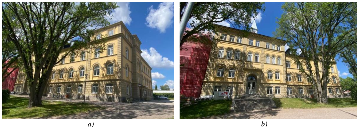
Figur 8. a) och b) Elin Wägnerskolan efter restaurering
