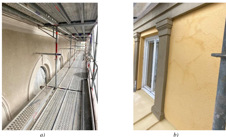
Figur 7. a) Innan restaureringsarbetet och b) Efter restaureringsarbetet, innan färgen torkat helt.
