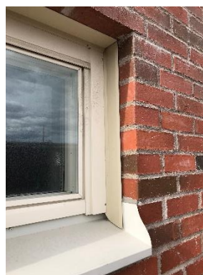
Figur 3b: Fönstersmyg på färdig byggnad.
