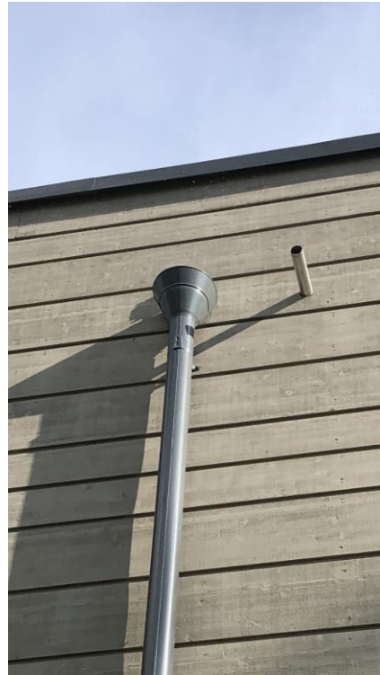
Figur 6b: stupröret på den färdig byggnaden.
