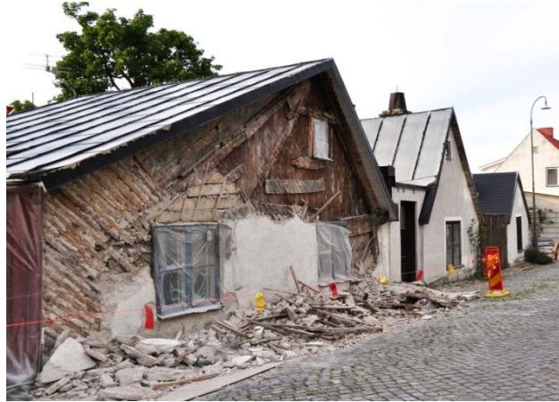
Även en putsad fasad kan dölja en trästomme. Här kan man se hur en träbyggnad successivt har förändrats, byggts ut och reverterats.
