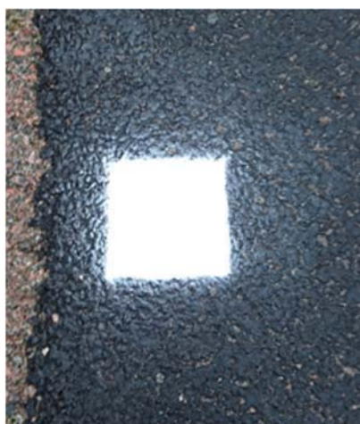
Figur 3. Flygsignal markerat med vitsprayfärg i storlek 20 x 20 cm.
