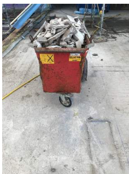
Figur 14: Sortering av betong
