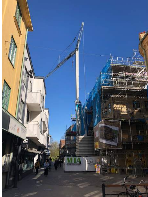
Figur 7: Kran med avlastningszon intill
