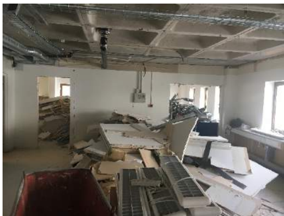
Figur 11: Sortering av rivningsmassor i våning
