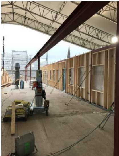
Figur 9: Pågående tillbyggnad etage 5
