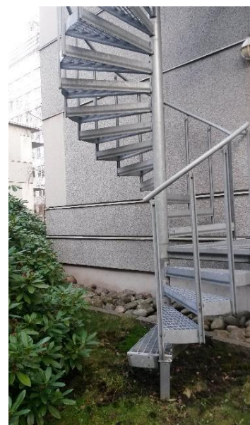
FIGUR 13: UTRYMNINGSTRAPPA SOM SLUTAR I BUSKAGE
