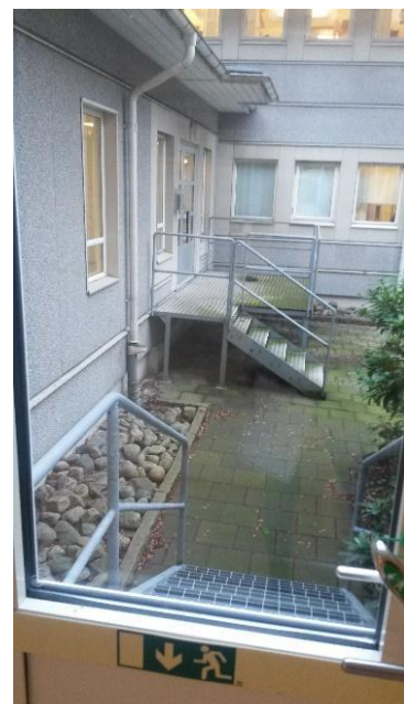
FIGUR 12: UTRYMNINGSVÄG SOM LEDER TILL TRAPPA I DET FRIA, LPA
