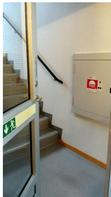
FIGUR 3: BRANDPOST I UTRYMNINGSTRAPPHUS I K
